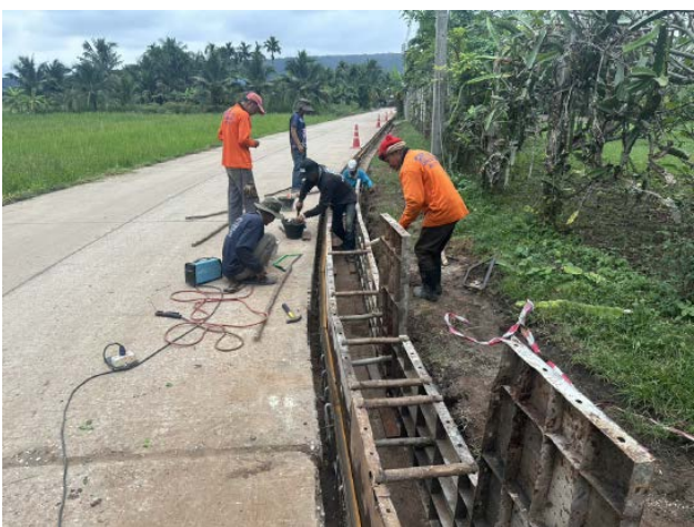
โครงการก่อสร้างวางระบายน้ำจากที่นายมนตรี-บ้านนางสาวธัญญา หมู่ที่ ๒
